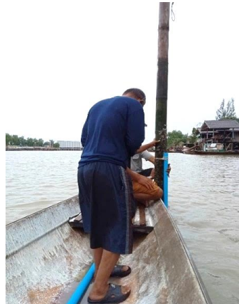
ติดตั้งอุปกรณ์เก็บค่าระดับน้ำ (Solinst Levellogger)
